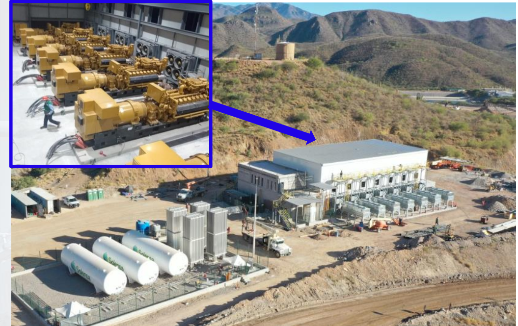
Santa Elena LNG Project – Commissioning in Q1 2021
