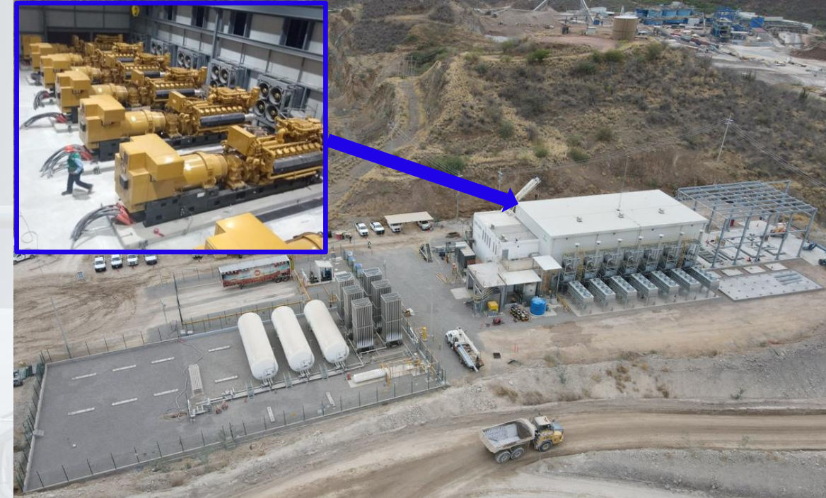
Santa Elena's LNG Power Plant
